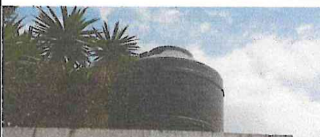
Foto 2: Sustitución o implementación accesorios para deposito de agua.
