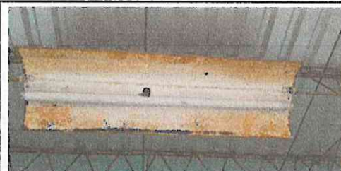
Foto 11: Sustrucción de plafoneras (salones, cocina, pasillos.)
