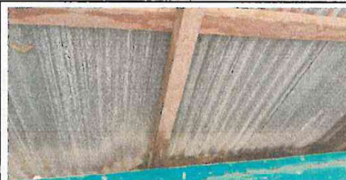
Foto 4: sustitución de lamina(acanalada) por lámina troquelada.
