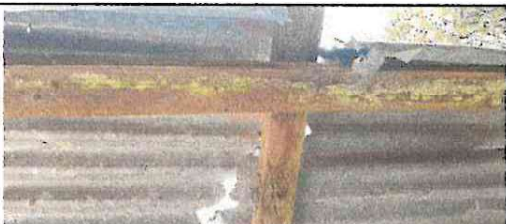
Foto 5: sustitución de estructura de soporte de (madera a metal)
