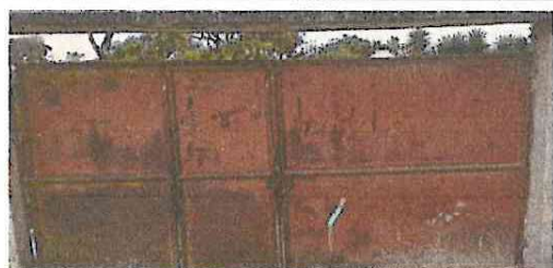
Foto 3: sustitución de portón de metal.
